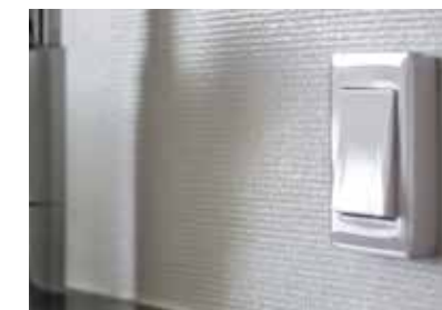
GLASFIBERVÄV Vitmålad G100-väv på vägg i tvättstuga och WC.
